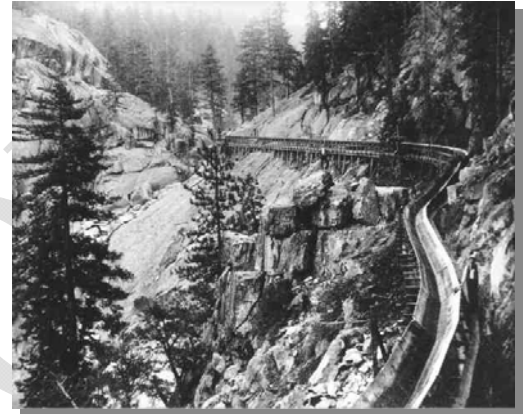
Canal para transporte de madera del Fresno, en la parte noreste de Fresno, década de 1920
